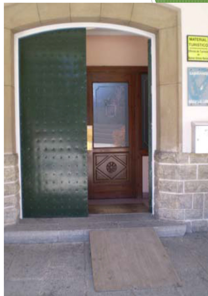
Acceso al edificio del Ayuntamiento de Sabiñánigo antes de la intervención
